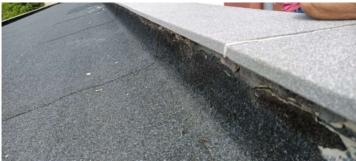
Detall tela asfàltica coberta centre cívic
