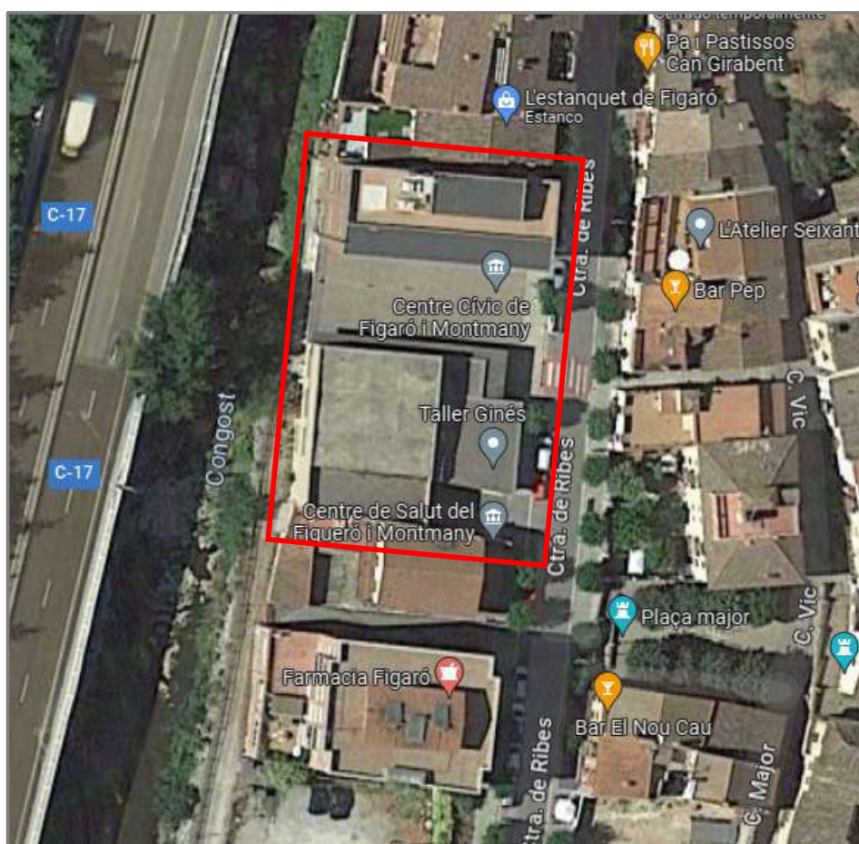
Vista general dels edificis
