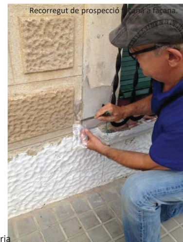
Extracció de microcates de les façanes seleccionades
