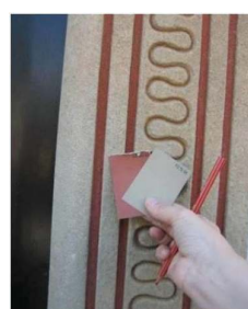
Contratipat cromàtic in-situ
