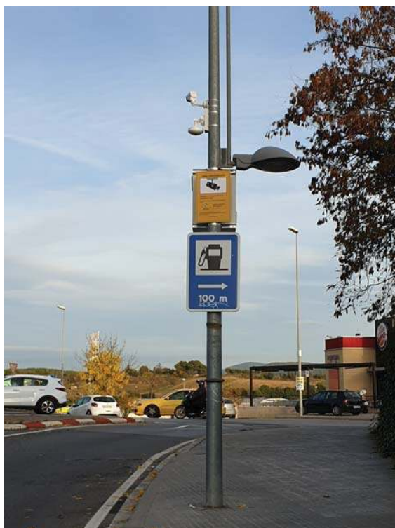
EXEMPLE D'EMPLAÇAMENT DE CÀMERA A FANAL
